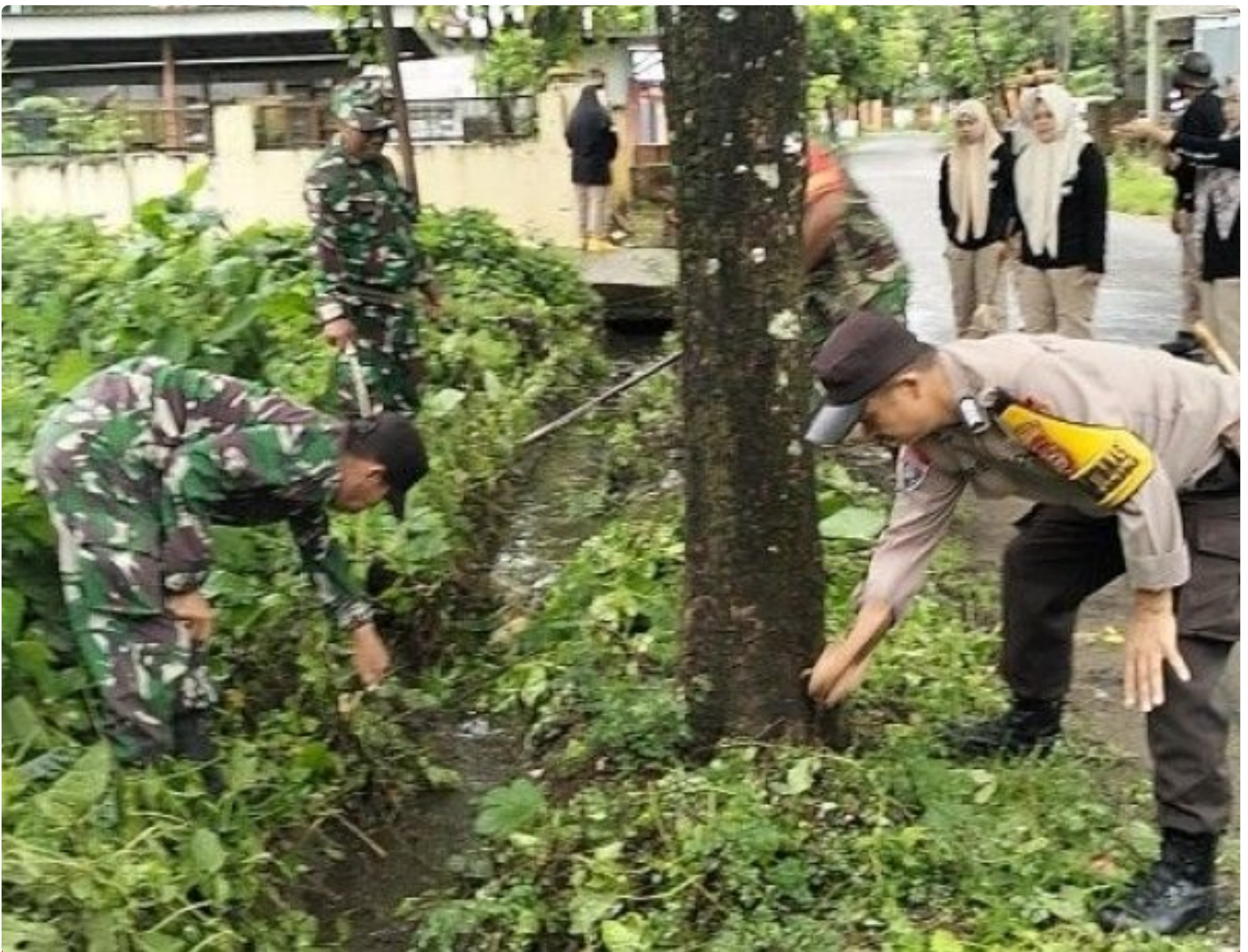
Gotong Royong Bersihkan Selokan, Koramil Minasatene Dorong Kepedulian Lingkungan
